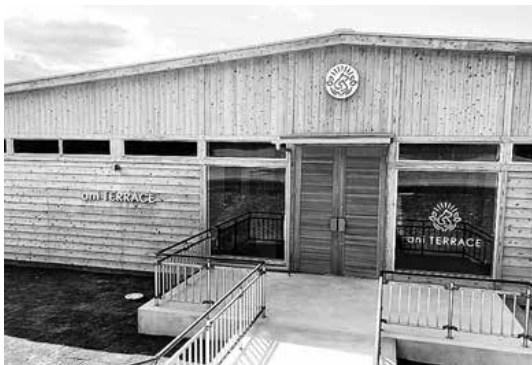
三重県多気町にオープンした「ani TERRACE」の外観
